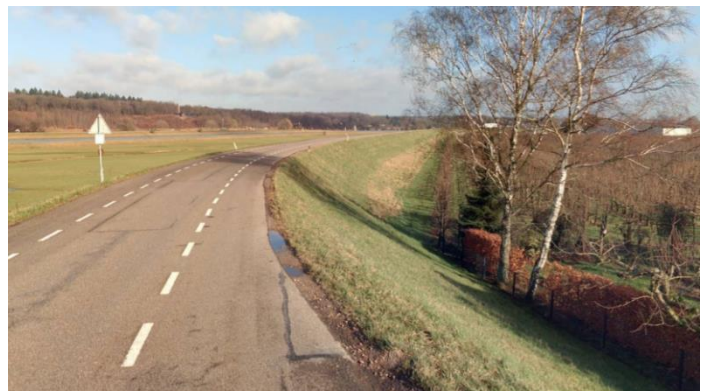
Figuur 12 Steil aflopend talud
